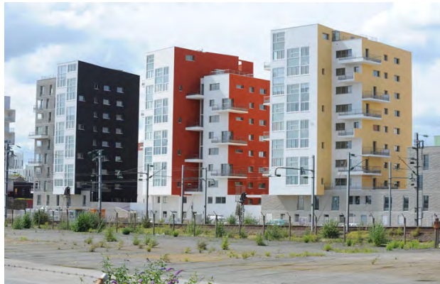
Nantes / Logements sur d'anciens terrains SNCF
