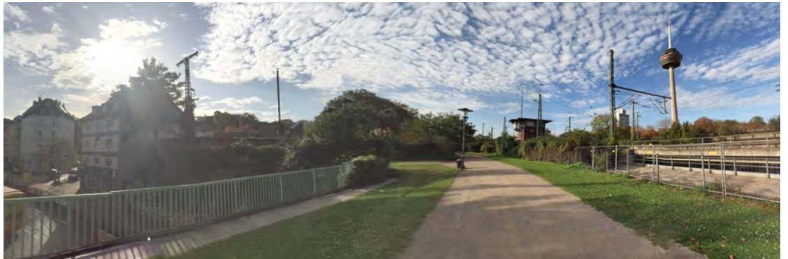
Cologne / Parc longeant les voies ferrées / passage en viaduc au dessus des voies routières
