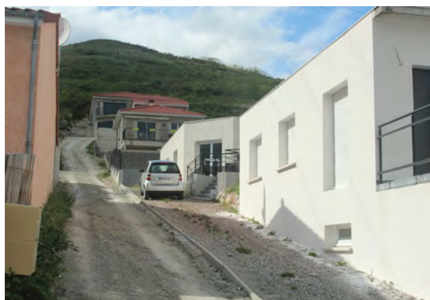
Constructions sur les Côtes
