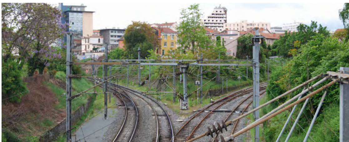
Débranchement de l'étoile ferroviaire, vue au droit de la rue Anatole France
