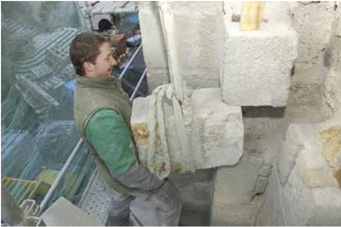
La restauration, l'atelier de taille de pierre
