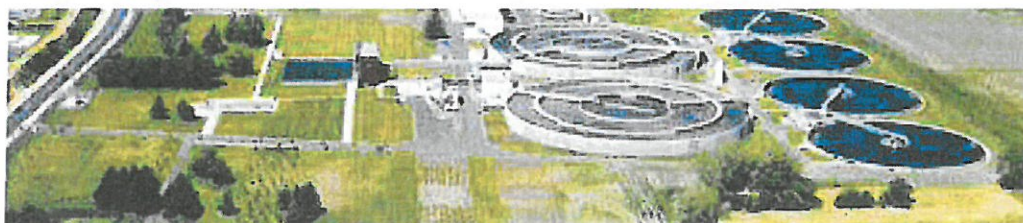
Station d'épuration des Trois rivières
