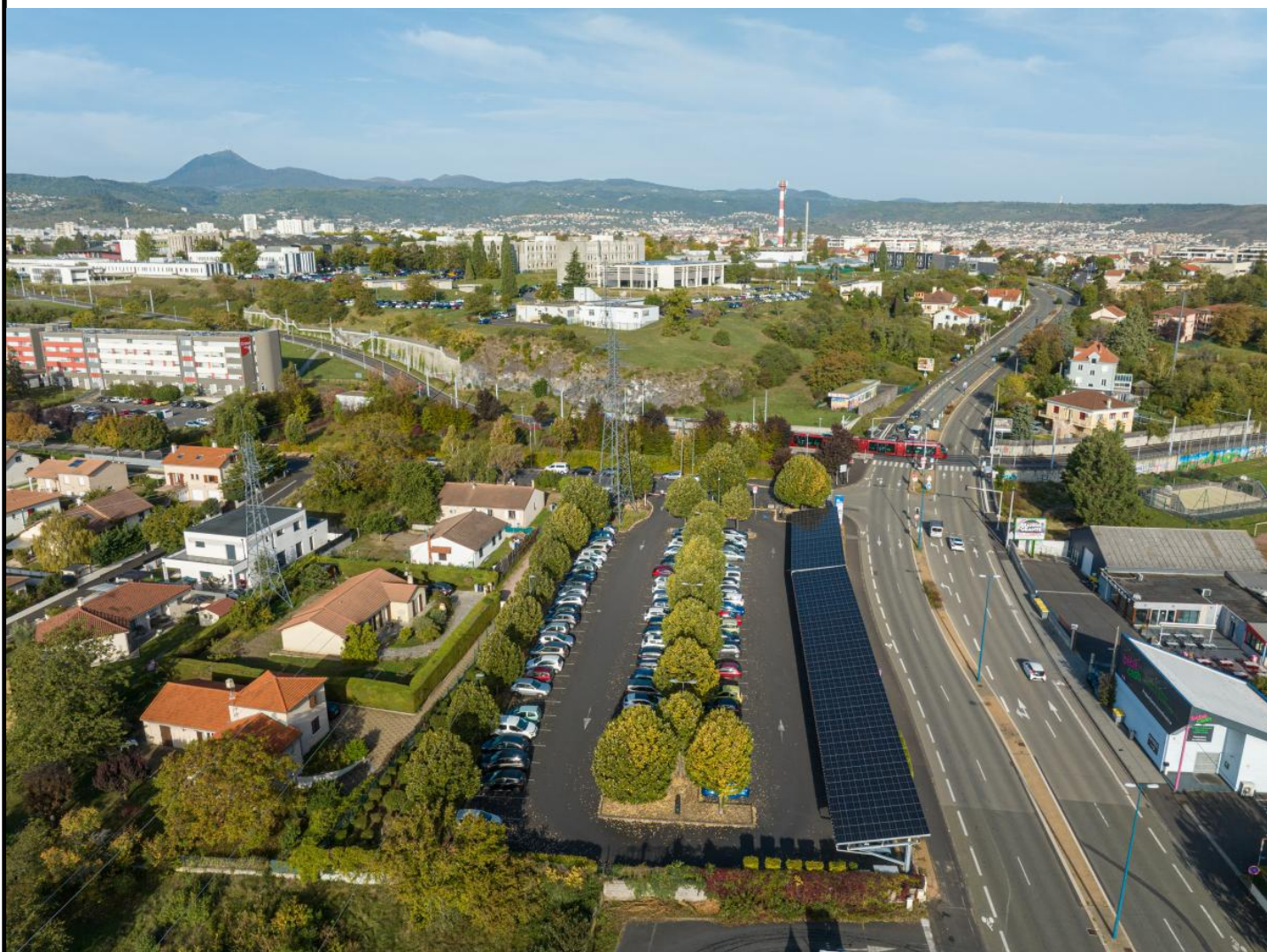
Ombrière photovoltaïque du parking-relais Margeride © Clermont Auvergne Métropole Jodie Way
