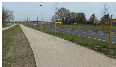
Chantier voie sud (mars 2022, SPL CA)
