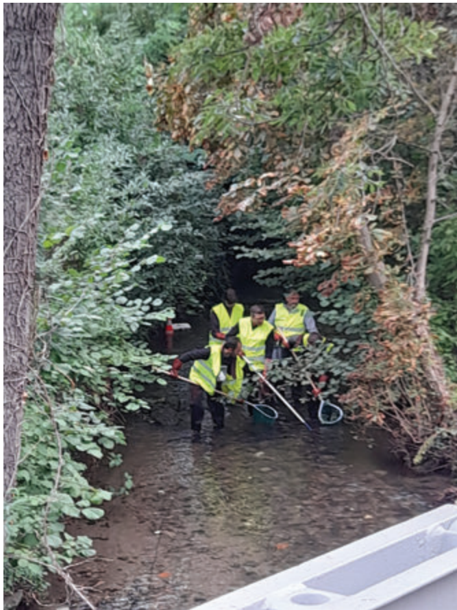
Pêche de sauvergarde sur le Bédard dans le cadre du chantier du collecteur nord.
