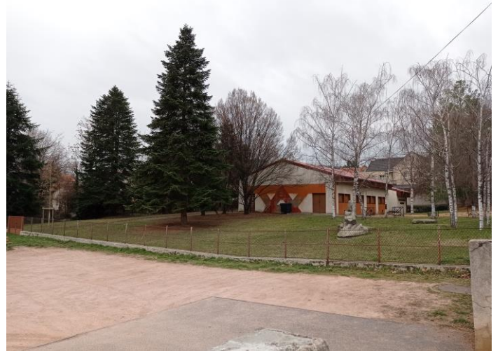
Vue du bâtiment depuis l'espace de parking
